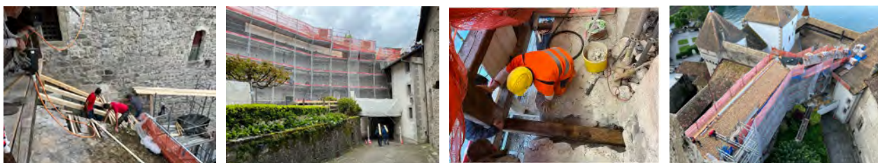
Travaux de restauration des courtines DEF, photos Antoine Graf, 2024
