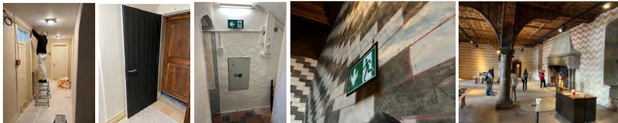
Travaux mise aux normes concept incendie : modification des installations au niveau des bâtiments OP et des salles Aula Magna et du Châtelain, photos Antoine Graf, 2024
