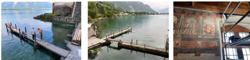
Travaux d'entretien : réfection du plancher du ponton à bateaux avec de nouvelles lames en chêne, zone extérieure Travaux de restauration : vidage des joints des panneaux de dépose, peintures murales de la salle des armoiries, salle U1 18, photos Antoine Graf, 2024
